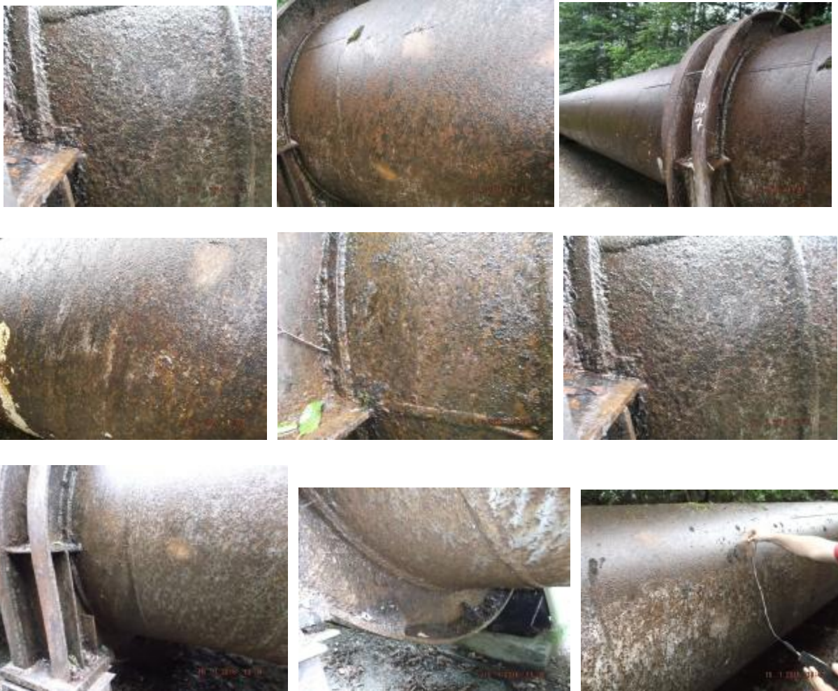
sur. 3. mi I sadenebis gare kdel ze arsebul i koroziul i dazi anebebi.
